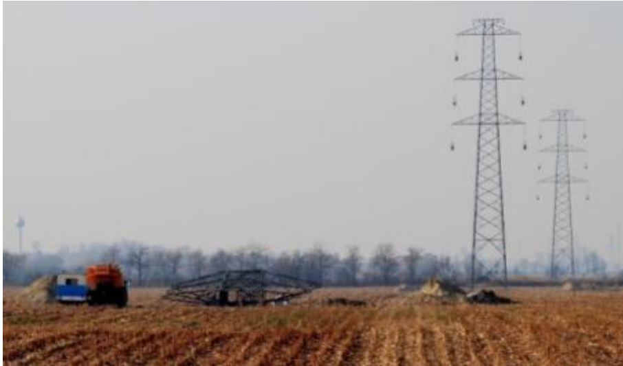
Figura 45: Linia electrică aeriană de 400 kV între Martonvásár și Győr, montarea stâlpilor
