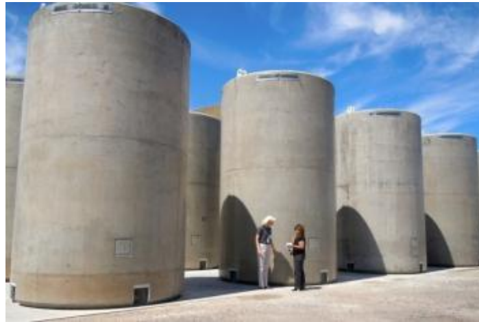
Figura 96: Depozitare uscată, în containere, în aranjament vertical [42]
