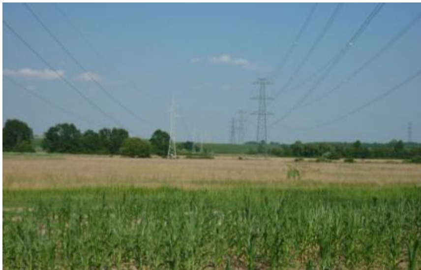
Figura 44: Linia electrică aeriană de 400 kV între Pécs și graniță, cu stâlpi în formă de brad, cu coridor pentru linie
